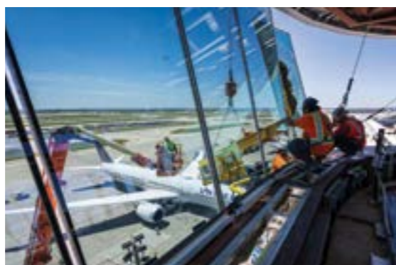
OD GÓRY: Wizualizacja nowego Terminalu 1 na międzynarodowym lotnisku im. Johna F. Kennedy'ego; prace budowlane na międzynarodowym lotnisku O'Hare w Chicago.
